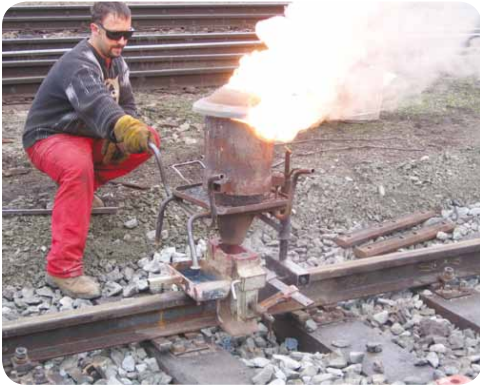
الشكل (٢-٩): استخدام تفاعل الثيرمايت في لحام خطوط السكك الحديدية.
