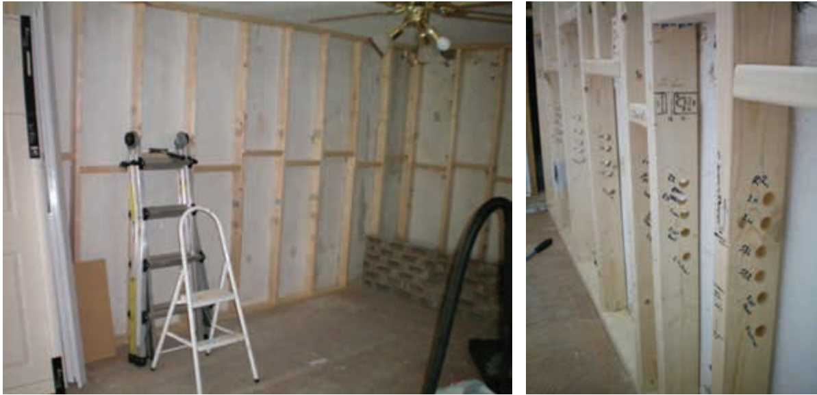
الشكل (٥٣-٢): عوارض طبقة البطانة مجهزة بثقوب للتمديدات الكهربائية وغيرها.
