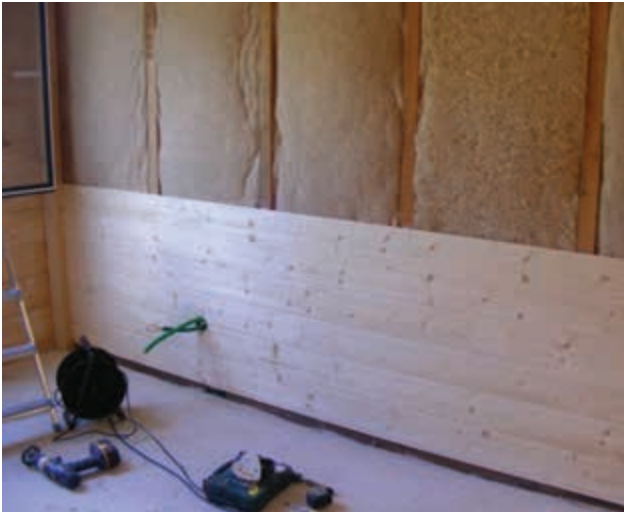
الشكل (٢-٥٦): جدار مغطى بألواح عرضية وطبقة عزل من الصوف الصخري.
