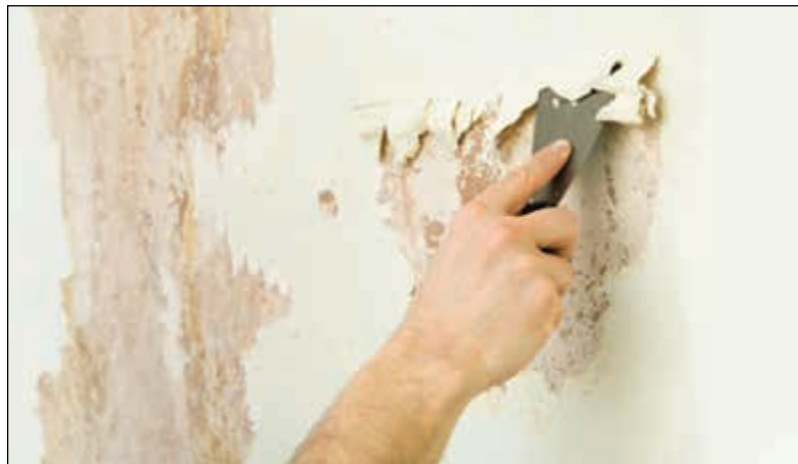
الشكل (٢-٥٠): إزالة الورق القديم عن الحائط.
