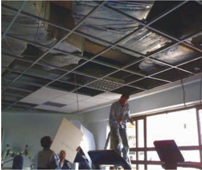
الشكل (٦٣-٢): تركيب بلاطات سقف معلق.
