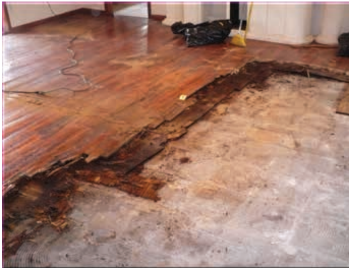
الشكل (٢ - ٢٢): أرضية خشبية تالفة.
