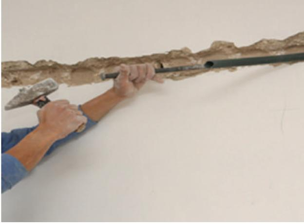
الشكل (٢-٤٣): التمديدات الكهربائية عن طريق الجدار.
