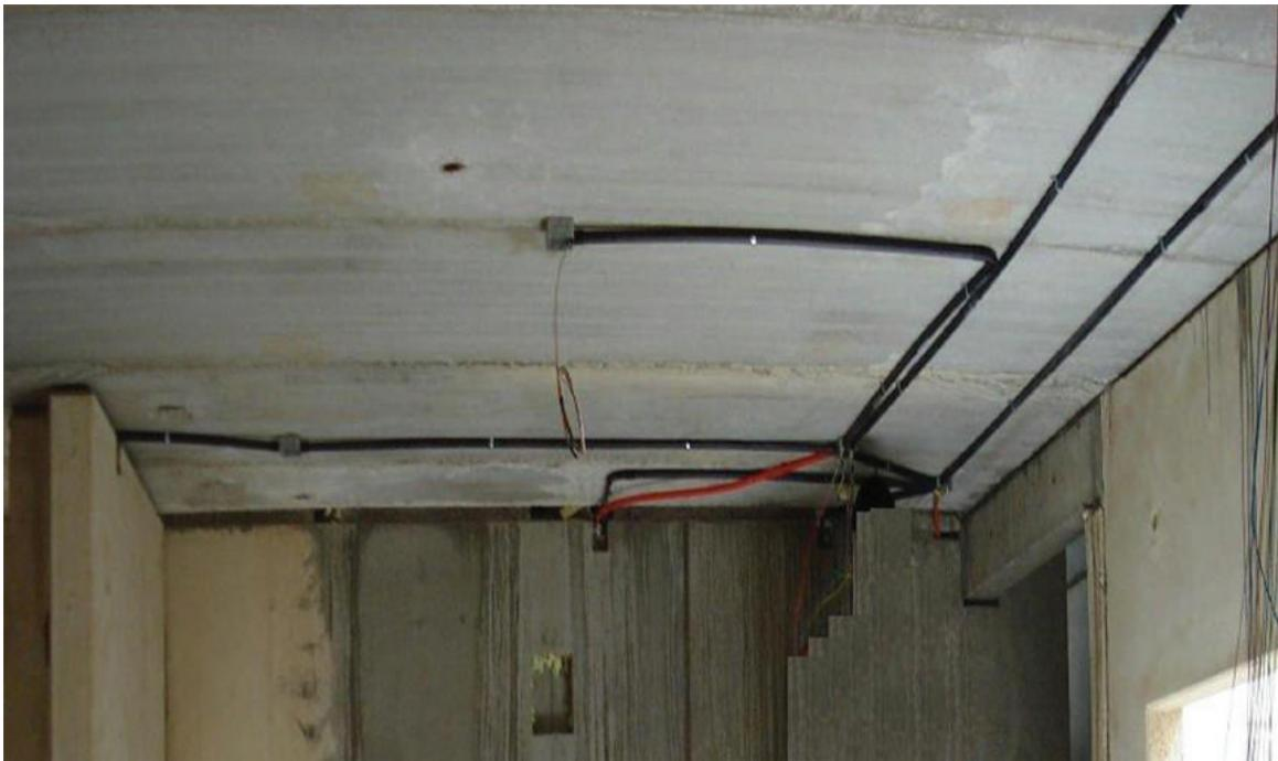
الشكل (٢-٤٢): التمديدات الكهربائية عن طريق السقف.
