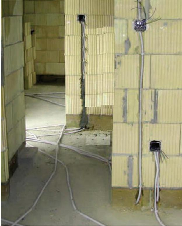
الشكل (٢-٤٤): التمديدات الكهربائية عن طريق الأرض.
